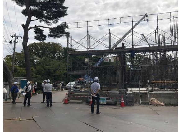
佐竹史料館建設工事
